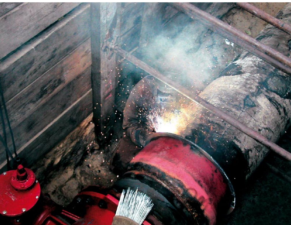
Schweißarbeiten an Gasrohr (Foto: NBB)
